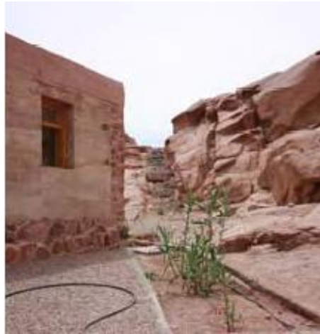
شكل (١-١٩) استخدام الجبس في تشطيب الواجهات، المصدر: مرجع سابق، Nashwa Ibrahim
