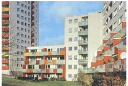
شكل (٢-٦) الدهان ذاتي التنظيف في مشروع STRUCKSBARG بألمانيا، المصدر: Enrico Ercolani, nano materials for architecture, material science and technology, universite di roma, 2011
