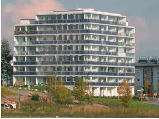
شكل (٢٠٢-٢٩) الخلايا الفوتوفولتية على البلكنات بأحد العمارات السكنية بفنلندا، المصدر: Marja Lundgren - KjellTorstensson, Photovoltaics in architecture - lessons learned in PV Nord , ARQ, 2004
