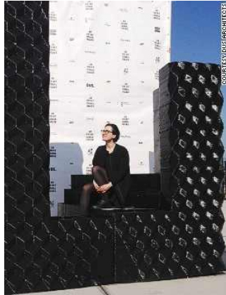
شكل (٢-٢-١٢) الاجزاء المطبوعة من المبنى، المصدر: Eoghan Macguire, " Dutch architects to build first 3d printed house ", 2014
