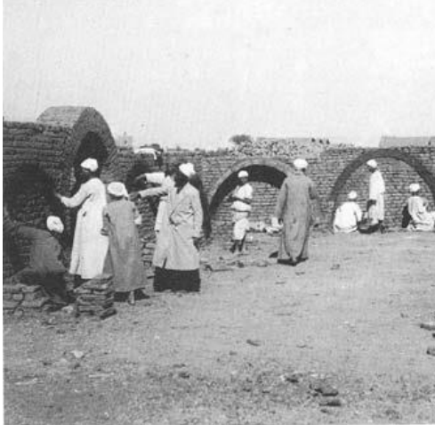
شكل (٢-٢٨) عملية البناء باستخدام الطوب اللبن
