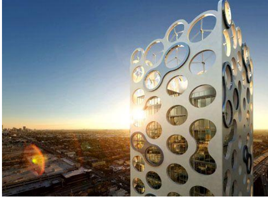
شكل (٢-٢-٤٣) استخدام الخلايا الفوتوفولتية و توربينات الرياح الصغيرة ببرج ميامي السكني بأمريكا، المصدر: www.archicentral.com
