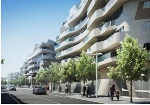
شكل (١٦-٢-٢) استخدام الخرسانة في مشروع سكني لرها حديد، المصدر: www.designboom.com
